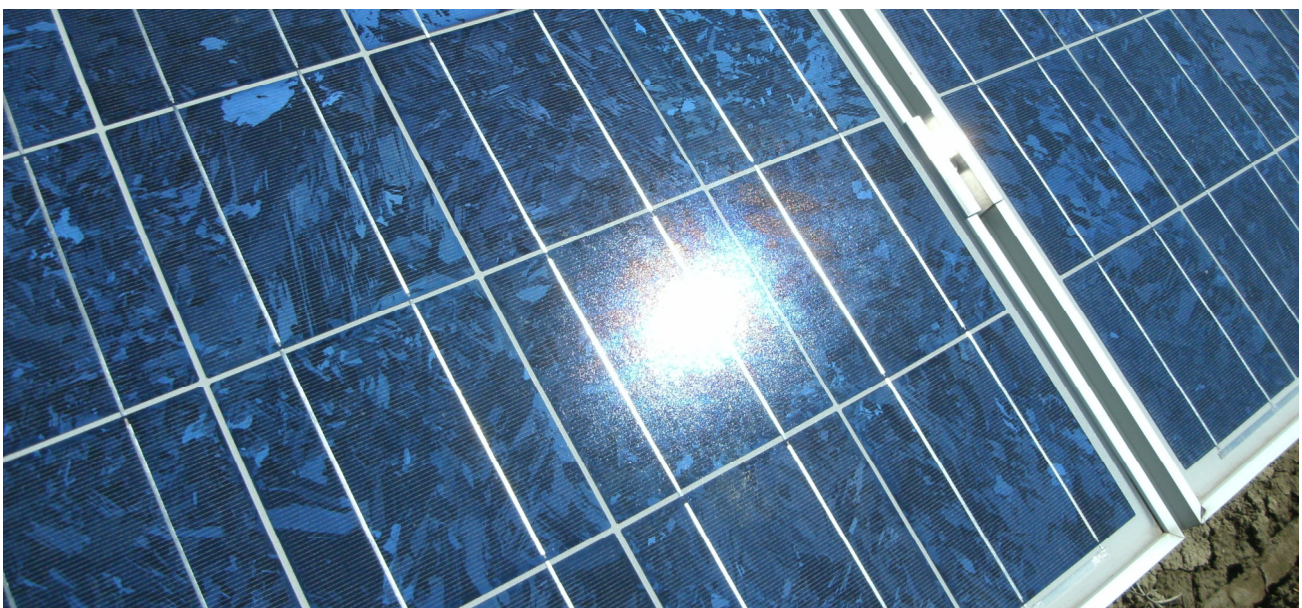
Bild S8: Diffuse Reflexion von direkten Sonnenlicht (Einstrahlung ca. 980 W/m 2 ) auf einem PV Modul (Quelle: SolPEG)
